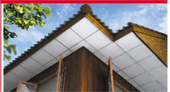
အပြင်ဘက် မျက်နှာကျက်အပုံ SCG SmartBOARD အနားစောင်း 4 mm အထူ အသုံးပြုထားပုံ
